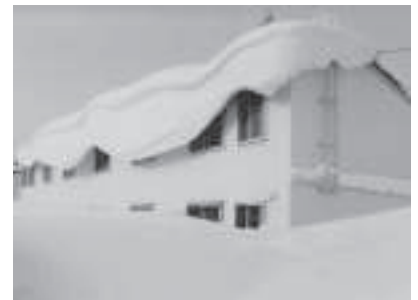
雪庇が覆いかぶさる町営住宅東町団地
