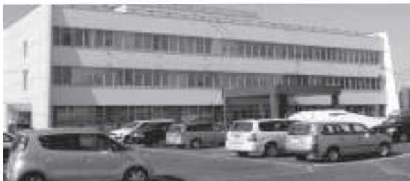
築42年が経過している役場庁舎
