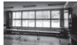
窓ガラスの耐震補強による安全性の確保を
