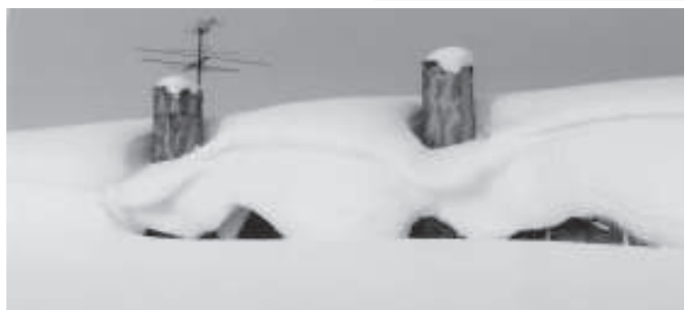
雪に埋もれた団地と今にも壊れそうな集合煙筒
