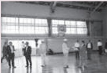
内装が終了した体育館
