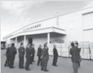
東川町内にある雪氷冷房冷蔵施設
