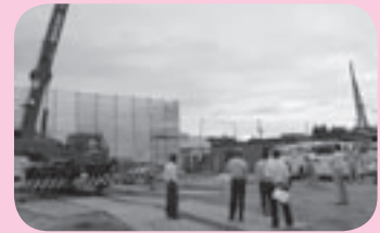
建設中の子ども発達支援センター
