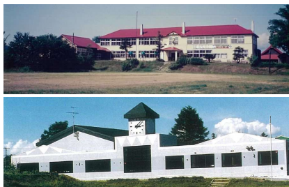
中小屋小学校 (上:旧校舎 下:新校舎)
