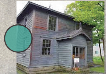
写真に建物が写っている…？
