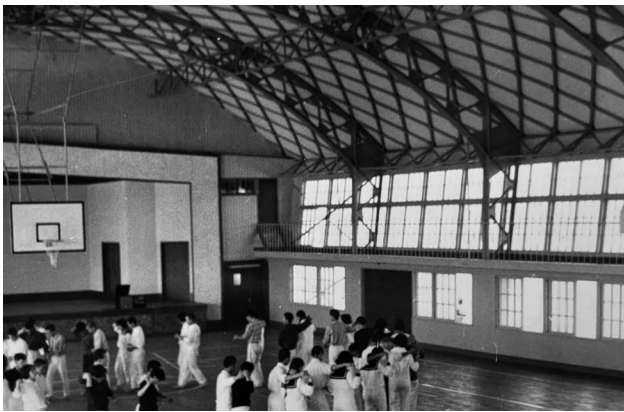
写真5 当別高校に完成した屋内体育館
