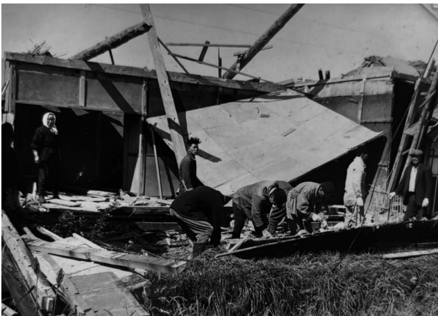
写真6 台風15号による被害の様子
