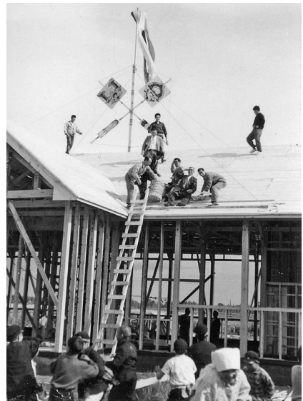
写真18 金沢小学校の上棟式（1961年）
