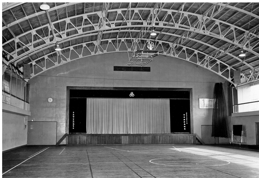
写真9 当別小学校に完成した体育館（1969年）
