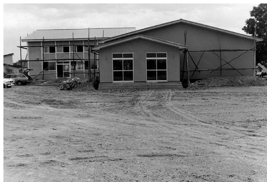
写真35 完成間近の鉄北幼稚園（1975年）
