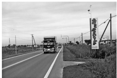
写真4 片側1車線だった国道275号の様子（1991年）
