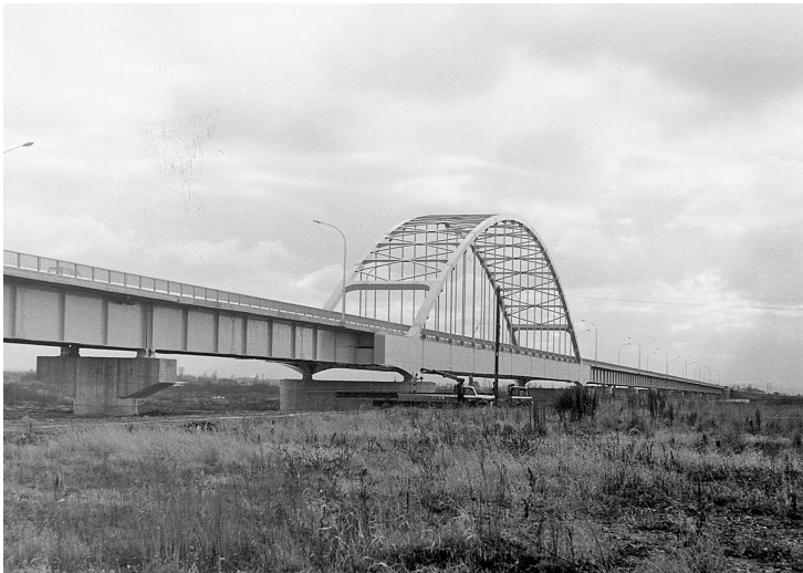
写真8 開通当初の新石狩大橋（1968年）
