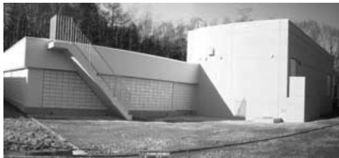
写真30 当別町配水池
