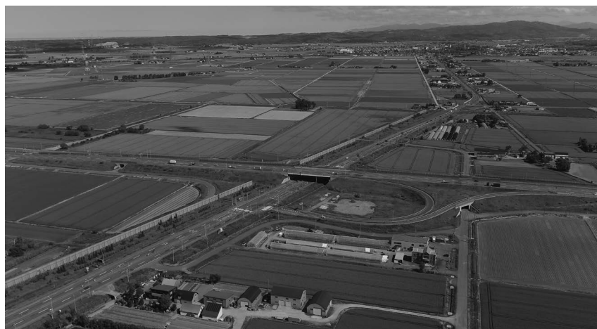
写真5 国道275号と国道337号が立体交差する蔵岱
