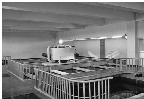
写真29 元町浄水場の内部（1974年）
