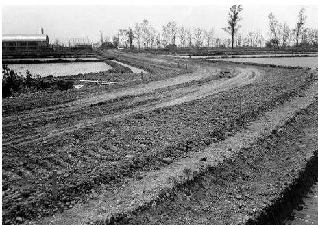
写真18 道路工事の様子（1972年）
