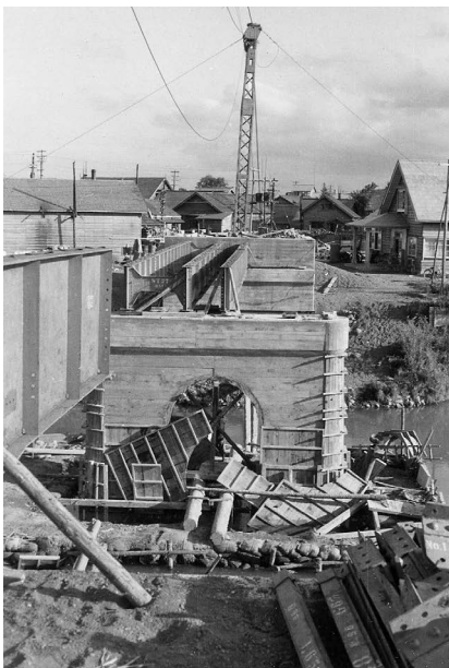
写真19 当別橋の建設（1958年）
