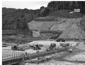
写真5 当別ダムの工事現場（2009年9月）
