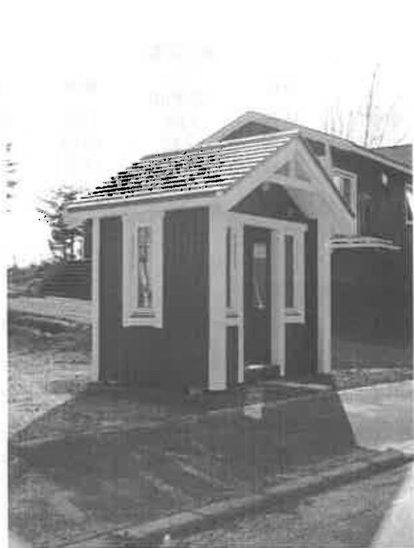
写真3-1-2 「ヒルズ管理センター」停留所
