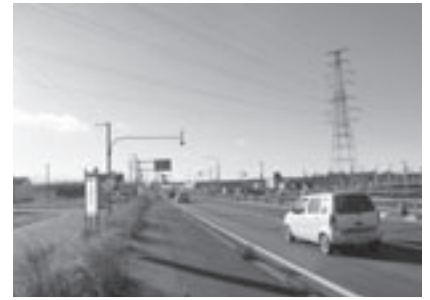
現在4車線化に向けて工事中の国道337号
