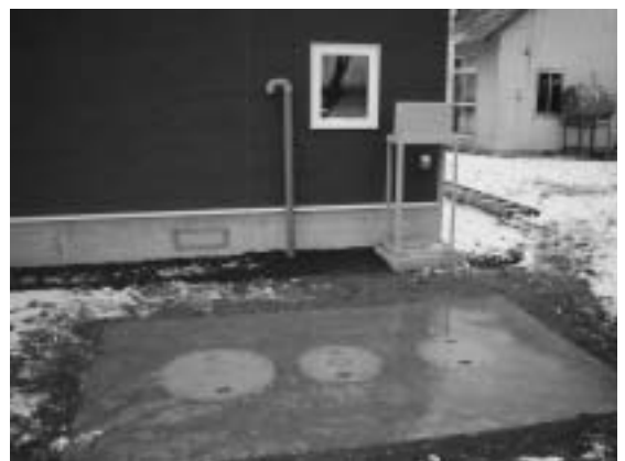
左上図の小型合併浄化槽が 地中に埋設され設置工事が完成
