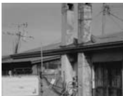
床も抜け今にも崩れ落ちそうな集合煙突（樺戸団地）
