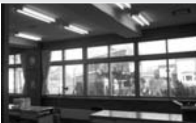
学校の照明器具
